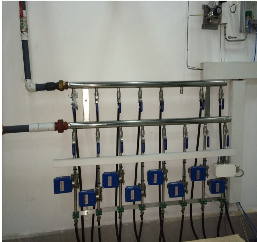
Figura 1.6 Distribución de Válvulas de flujo
