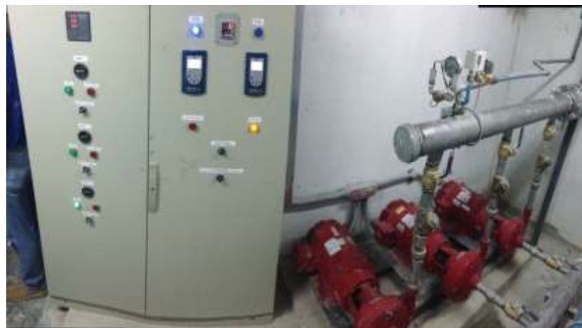
Figura 2.2: Equipo de presión constante por velocidad variable
