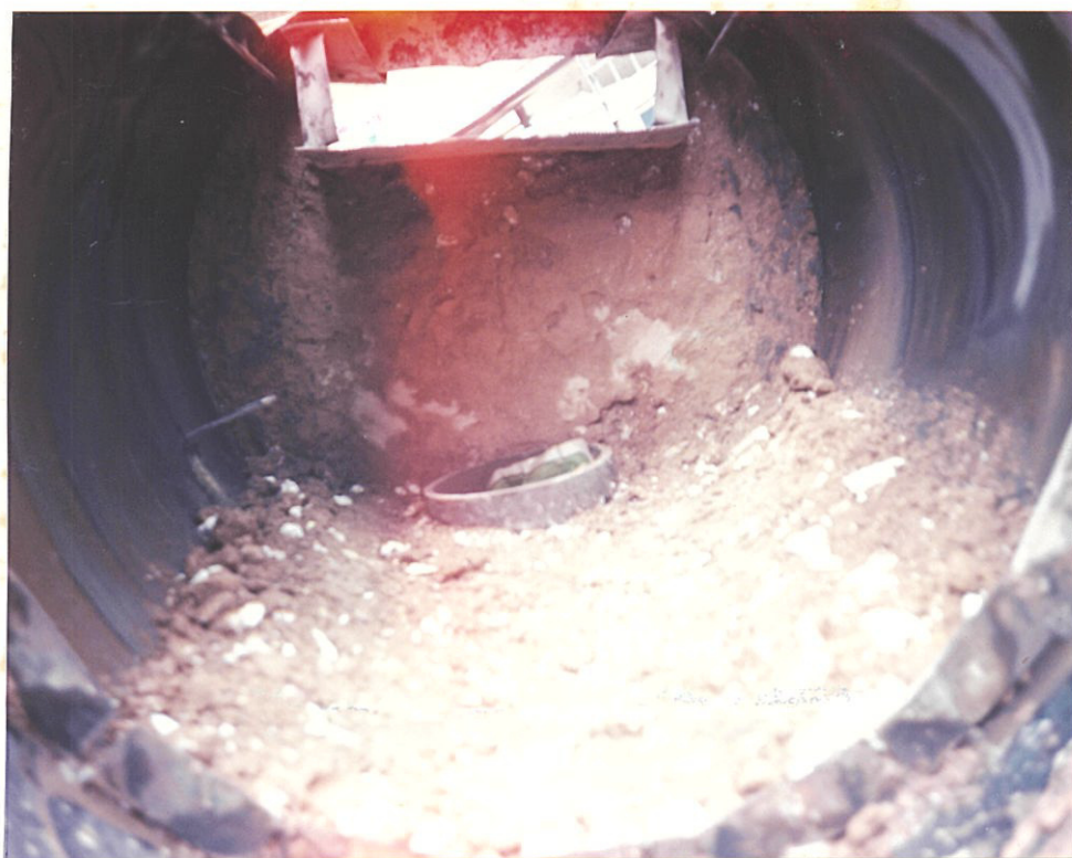
FIG. 2.7 SECUENCIA DEL PROCESO DE REVESTIMIENTO DEL HOGAR
