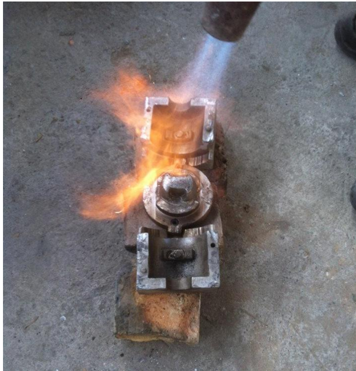
Figura b-3 Calentamiento del molde
