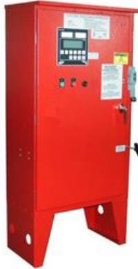
**Figura 3.7. Tablero de control para bomba principal Edificio Administrativo Ref. 21**
