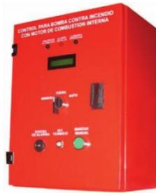
**Figura 3.11. Tablero de control para bomba del Edificio de Postgrados Ref. 32E**
