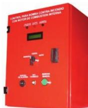
**Figura 3.14. Tablero de control para bomba del Edificio de Aulas Ref. 32C**
