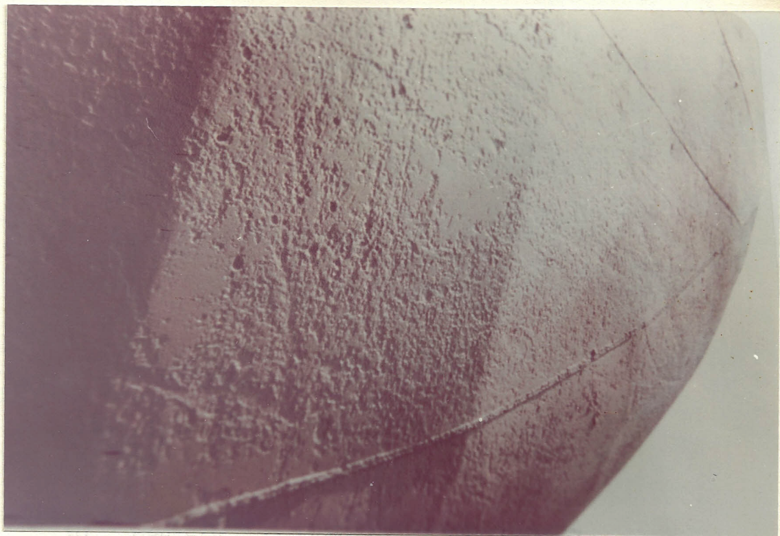
Fig. Nº 12 Parte del planchaje de la obra viva del dique Amazonas.
