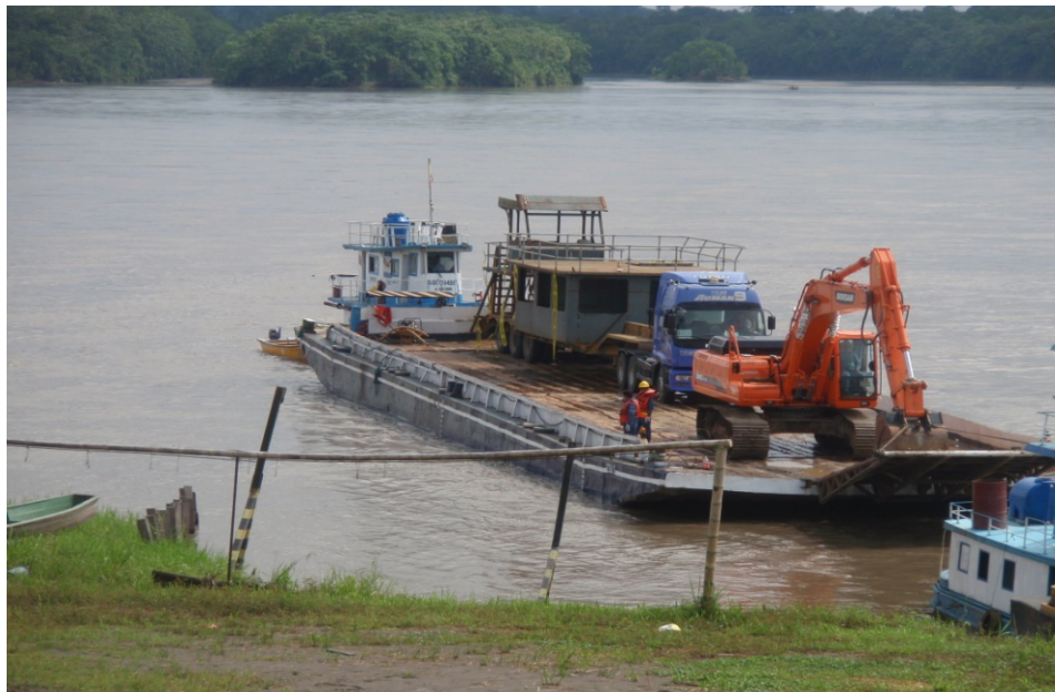
Figura 1. Movilización de Equipos sobre gabarra
