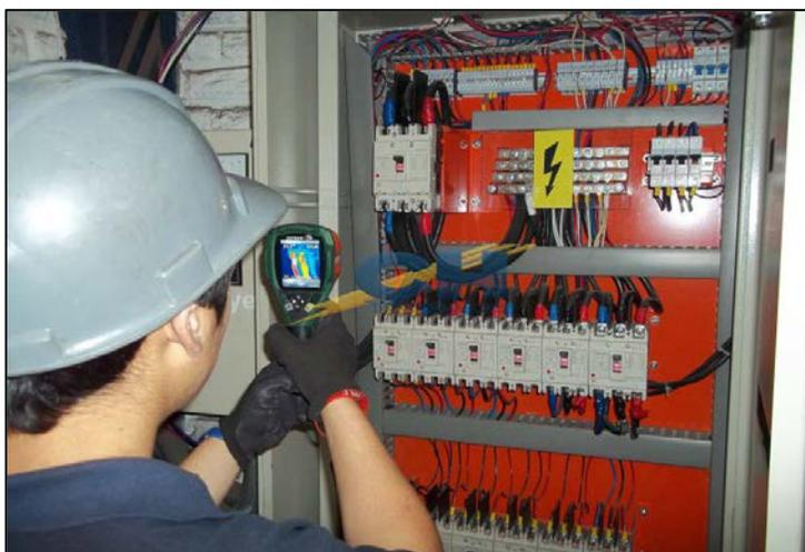
**Fig. 23** Análisis termografico de panel eléctrico
