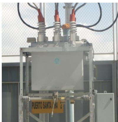
Figura 1.9 Estructura de Seccionadores de las Alimentadoras
