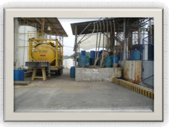
Foto 1. Área de Despacho
