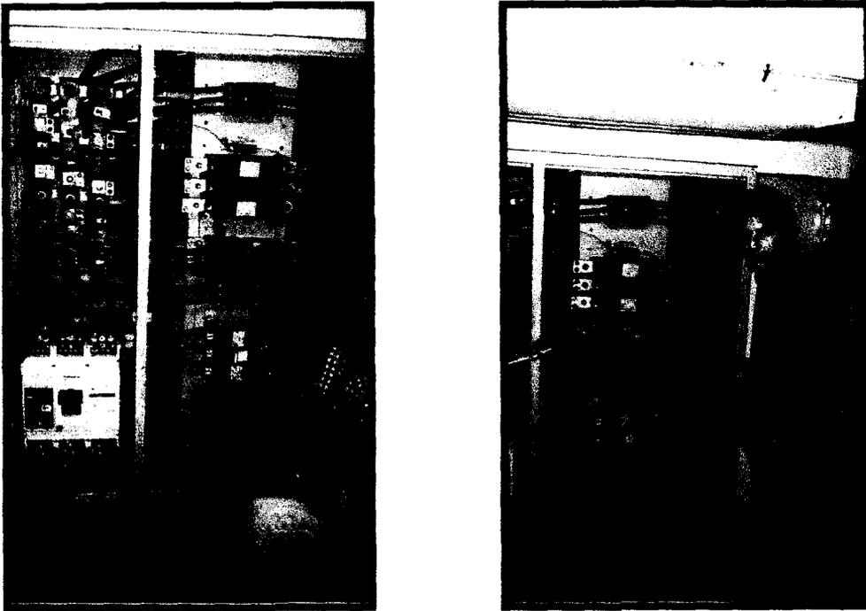
**FIG 3.2 Panel de Distribución Principal (Banco de Transformadores 501 KVA)
