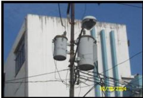
**FIG. 4.3 Banco de Transformadores de 125 KVA**
