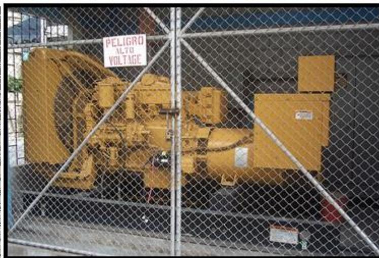
**FIG 3.7 Grupo Electrogeno 500 KVA, ubicado en la pared lateral del Edif. de Producción**
