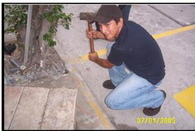
**FIG. 5.2 Colocando la varilla cooperweld de 1.80 m**
