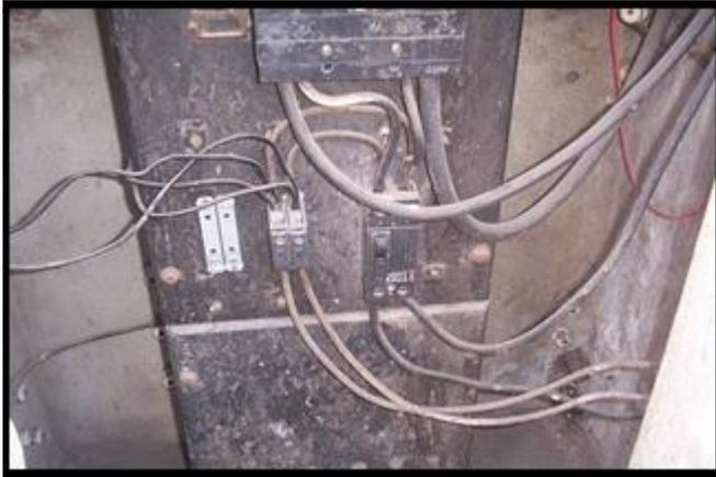
**FIG. 5.1 Centro de carga #3 (75 KVA) ubicado en la parte lateral del Edif. Directorio**
