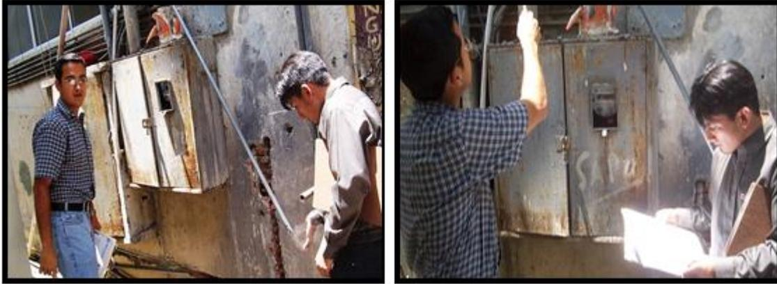
**FIG 3.3 Tablero de Distribución (125 KVA), Ubicado en la parte posterior de Medio de Cultivos**
