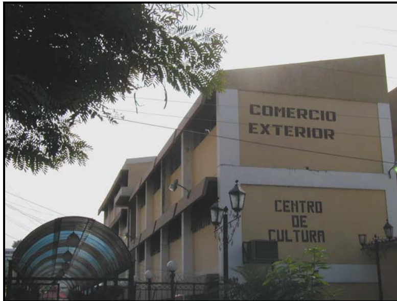
Fig. 5.17 Edificio Comercio Exterior
