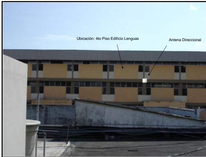
Fig. 6.6 Ubicación de Antena en Edificio Lenguas
