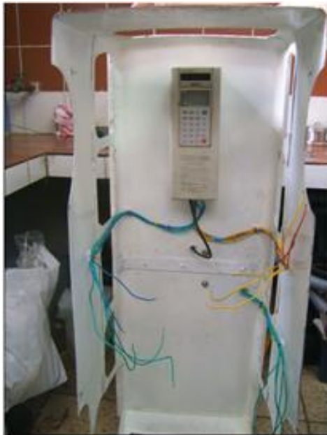
Posición del Inverter en el bus
