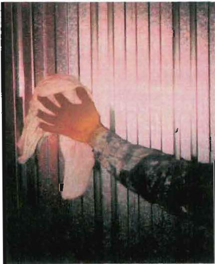
Procedimiento que se utiliza para remover materiales extraños perjudiciales tales como: aceite, grasa, manchas y otras contaminaciones de la superficie del acero mediante el uso de solventes, emulsiones, compuestos limpiadores, limpieza con vapor o materiales y métodos similares, los cuales determinan una acción solvente o limpiadora.
