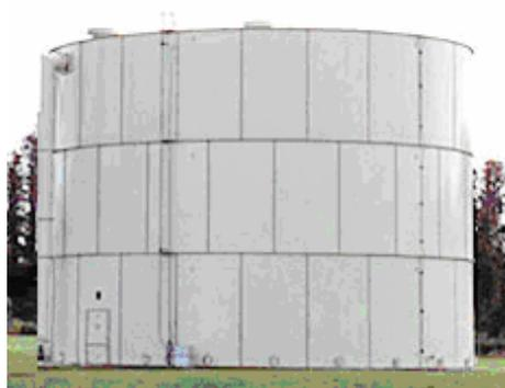
**FIGURA 3.20. TANQUE CILINDRICO DE FONDO PLANO.**
