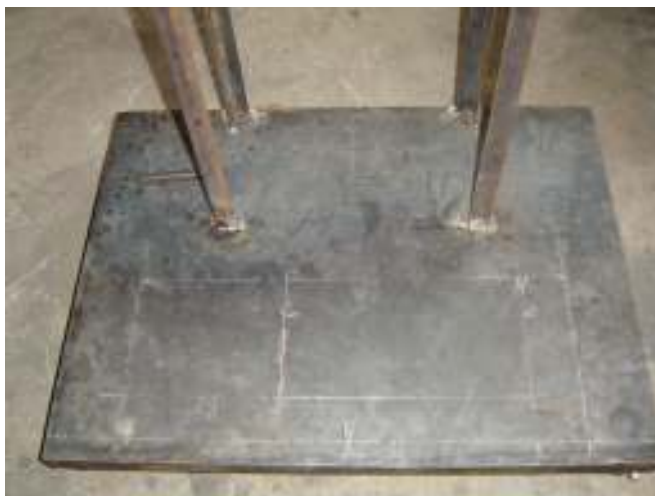
Figura 26. Base Metálica de estructura
