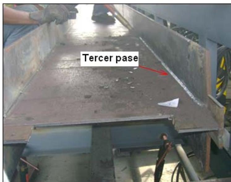
FIGURA 4.40: SOLDADURA DEL TERCER CORDÓN CON SAW.
