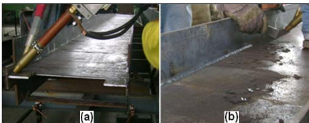
**FIGURA 4.34: SOLDADURA DEL PRIMER CORDÓN CON SAW.**
