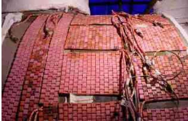
**FIGURA 2.20: TRATAMIENTO TÉRMICO A UN TANQUE CILÍNDRICO**
