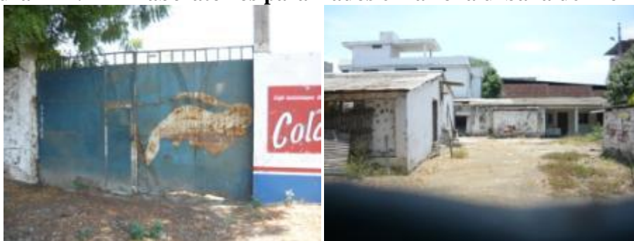
Figura # 42. Laboratorios paralizados en la zona urbana de Montecristi
