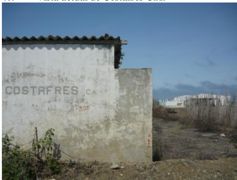
Figura # 40. Vista actual de Costafres C.A.
