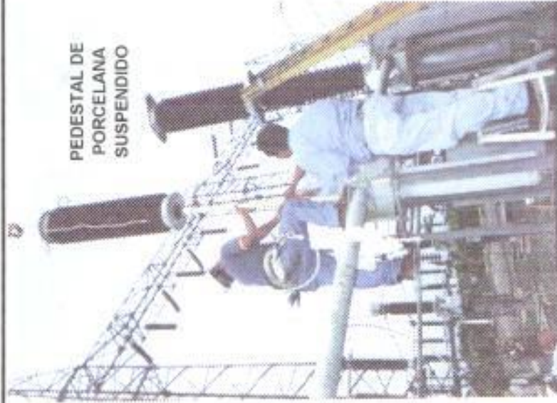
DESMONTAJE DEL PEDESTAL DE PORCELANA VISTA DEL BRAZO TRANSMISOR DE MOVIMIENTO Y EMPAQUES A CAMBIAR PROCESO 12
