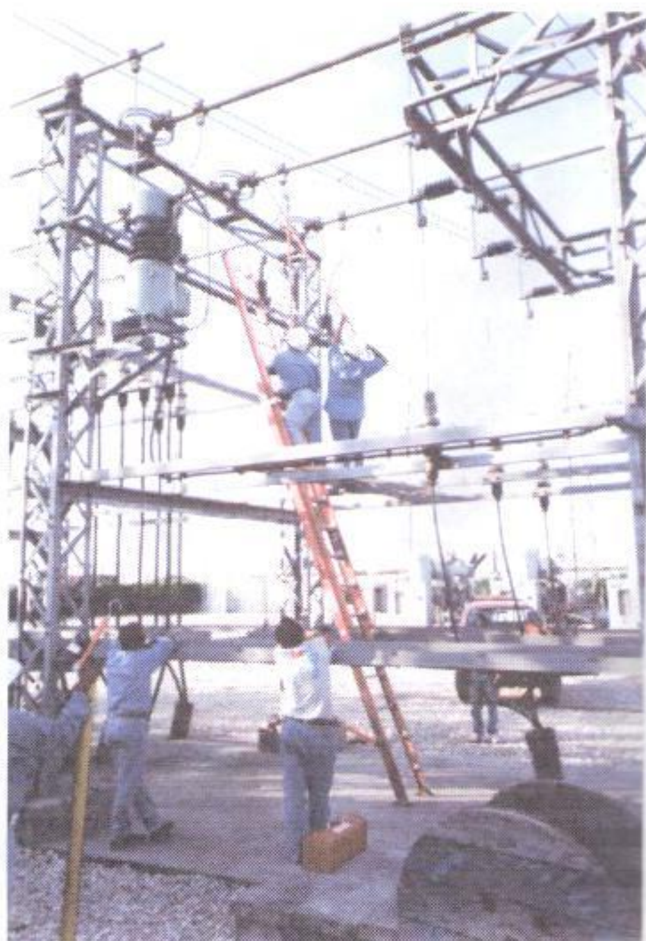
TRABAJOS EN BARRAS TERCIARIAS (ALIMENTACIÓN S.S.A.A.)
