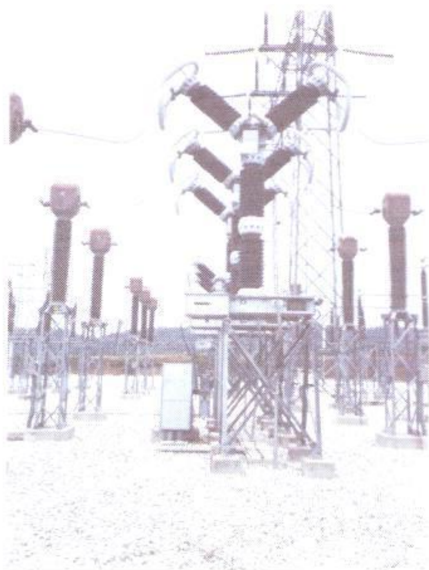
FIG. 5.2 Disyuntor CENEMESA tipo columna 230 KV S/E Pascuales
