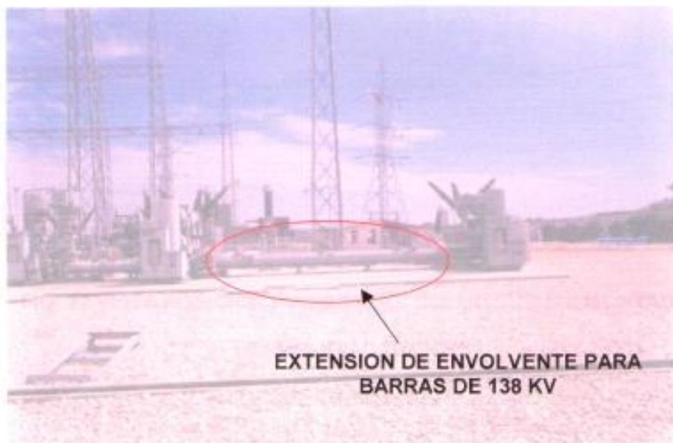
FIG. 21 VISTA POSTERIOR DE LOS MAHOLES Y UNIONES TIPO ACORDEON EMPLEADOS EN EL MONTAJE DE LA POSICION GIS 138 KV (S/E TRINITARIA)
