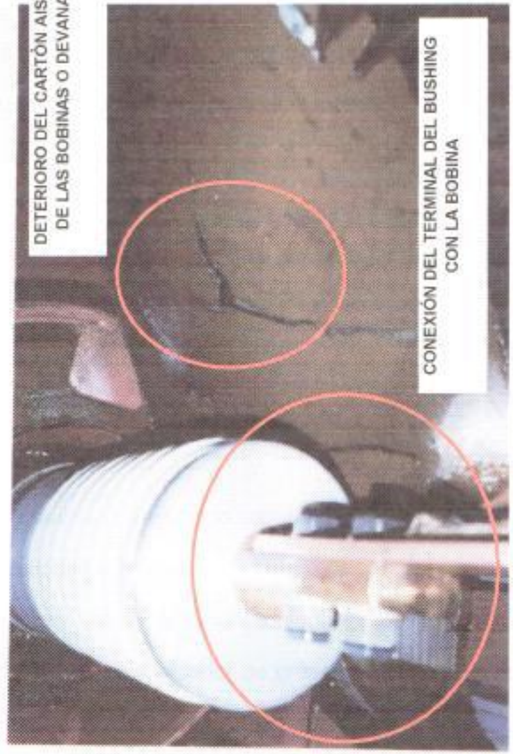
VISTA INTERIOR DE LA CONEXIÓN DEL TERMINAL INFERIOR DEL BUSHING CON LA BOBINA DE 69 KV PROCESO 5 Y 6 FOTO 10
