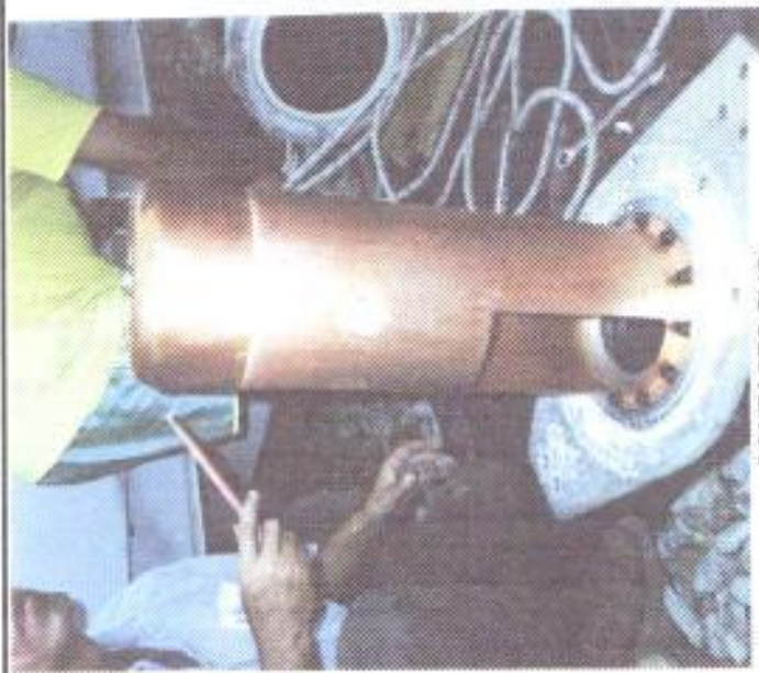
CONTACTO FIJO (HEMBRA) PARTE SUPERIOR DE LA CAMARA DE CORTE
