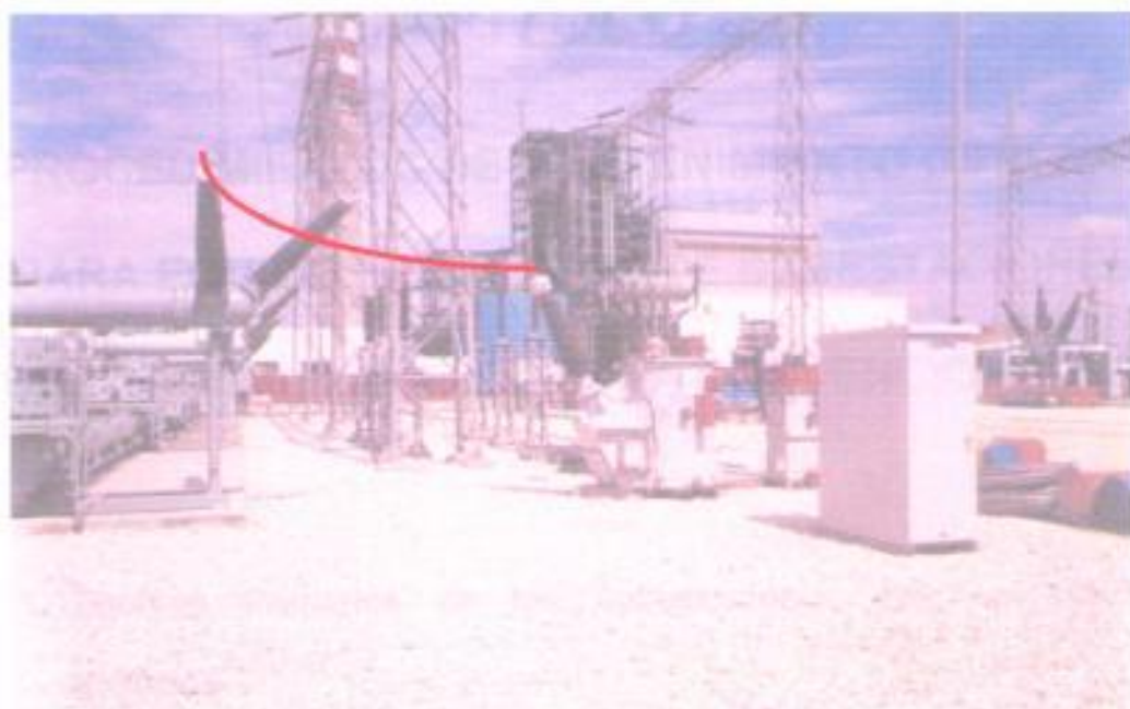
FIG. 23 UBICACIÓN DEL REACTOR PARA PRUEBA DE ALTO VOLTAJE
