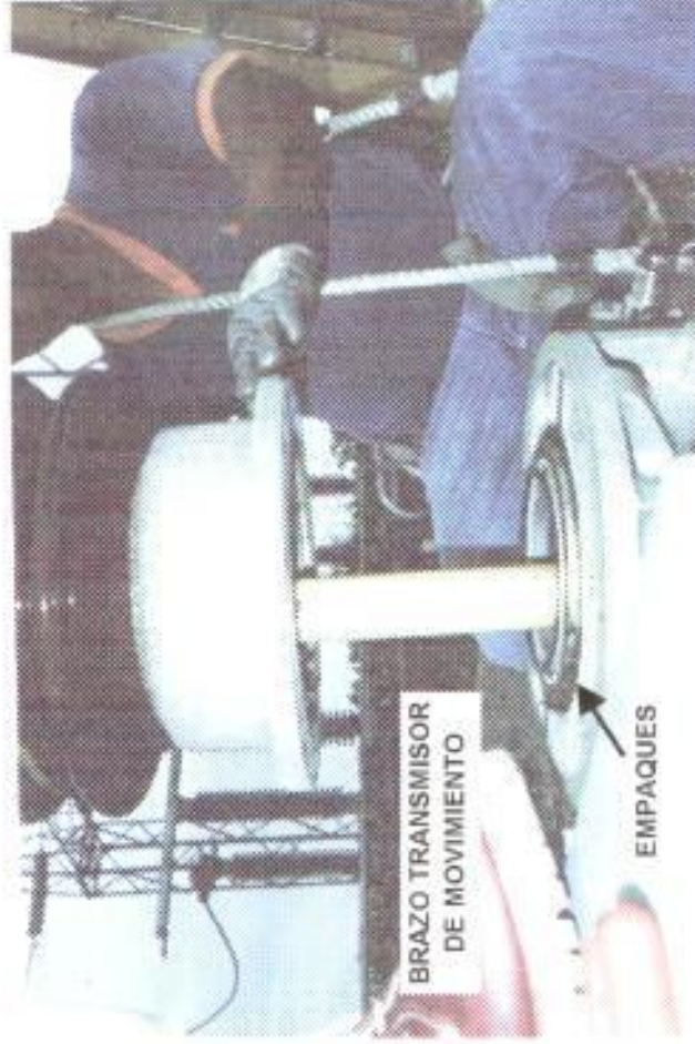
DESMONTAJE DEL PEDESTAL DE PORCELANA VISTA DEL BRAZO TRANSMISOR DE MOVIMIENTO Y EMPAQUES A CAMBIAR PROCESO 12
