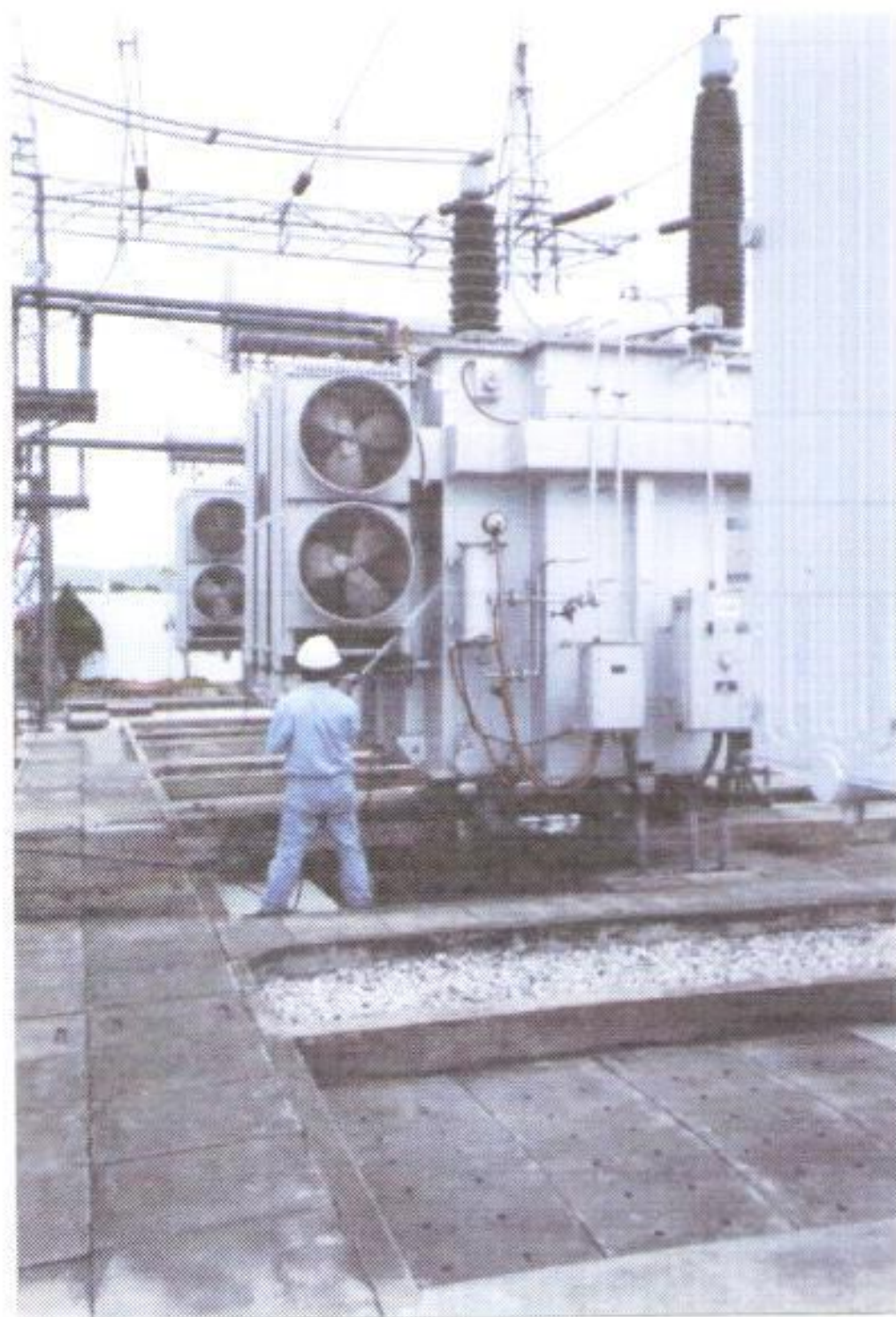
FIG. 5.13 Limpieza exterior de autotransformador 1Ø
