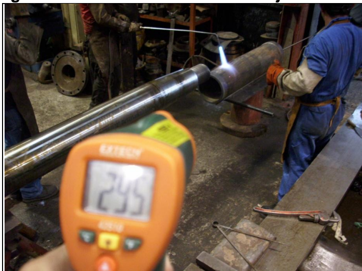
Figura 3.2.8: Puesta en caliente en eje de camisa
