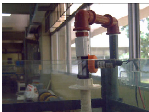
FIGURA 3.3 CONEXIÓN DE MEDIDOR DE CAUDAL A ENTRADA DE TANQUE.
