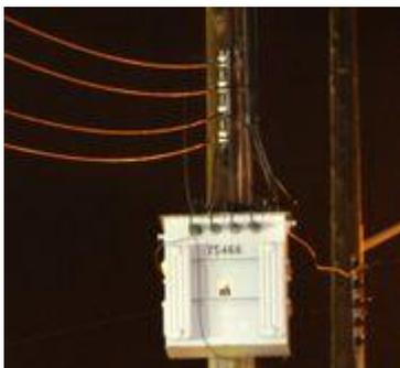
Se denomina transformador a una máquina electromagnética que permite aumentar o disminuir el voltaje o tensión en un circuito eléctrico de corriente alterna, manteniendo la frecuencia. La potencia que ingresa al equipo, en el caso de un transformador ideal, esto es, sin pérdidas, es igual a la que se obtiene a la salida. Las máquinas reales presentan un pequeño porcentaje de pérdidas, dependiendo de su diseño, tamaño, etc.
