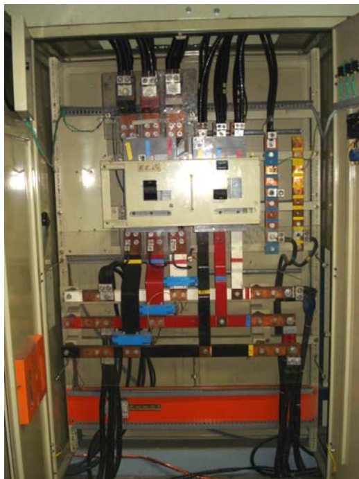
Figura 19.- Tablero de distribución de Senefelder, sistema 208/120 (foto tomada sin flash)
