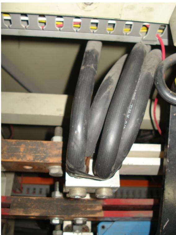
**Figura 24.-** Se observa la excesiva curvatura de los cables conectados a la barra, se observa también acumulación de polvo sobre las barras
