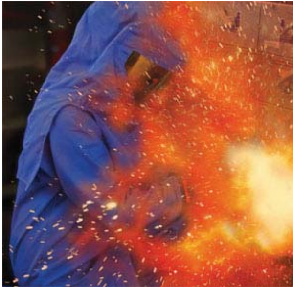
Fotografía 1.- Explosión de arco llamarada. Tomado de la página web de Electrical Products & Solutions www.epsmag.net
