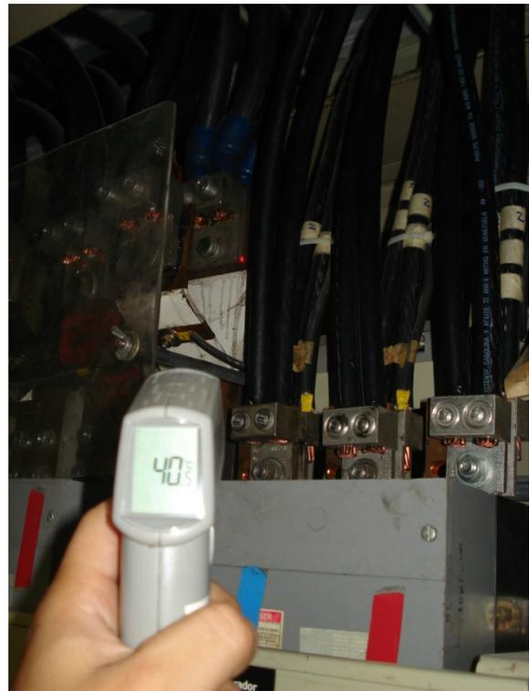
**Figura 26.- temperatura medida en uno de los juegos de cables conectados a las barras.**
