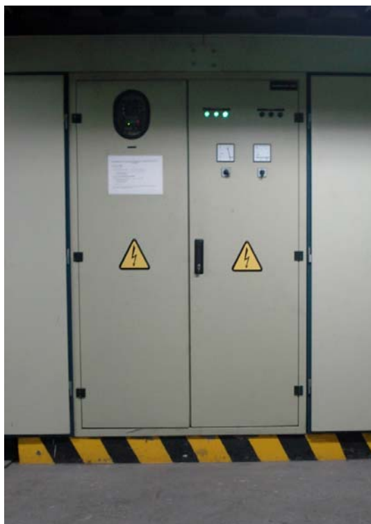
Figura 19.- Tablero de distribución de Senefelder, sistema 208/120 (foto tomada sin flash)
