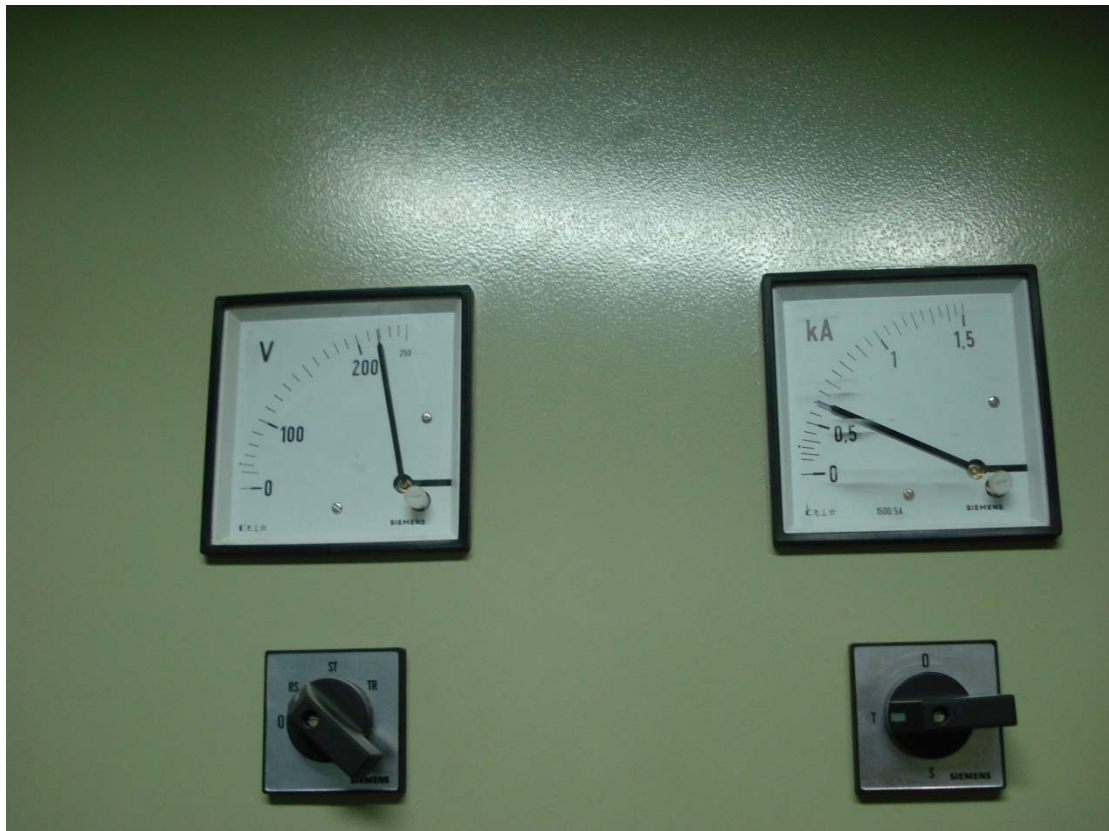
Figura 27.- Valor de corriente medido en el momento de la evaluación, I = 600 \text{ A}
