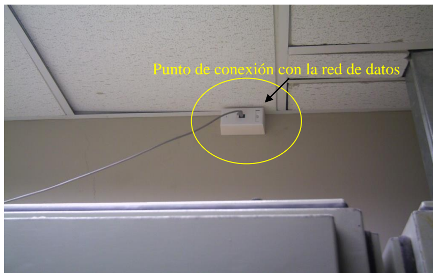
Figura 5-7. Punto de conexión con la red de datos.
