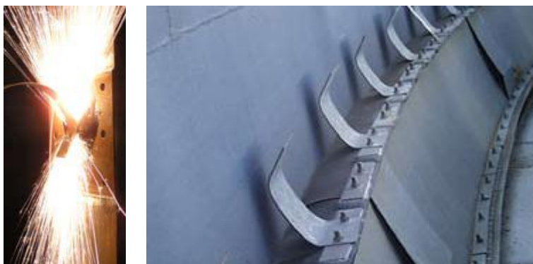
Fig. 5.2 Esquema instalación del dispositivo de puesta a tierra
