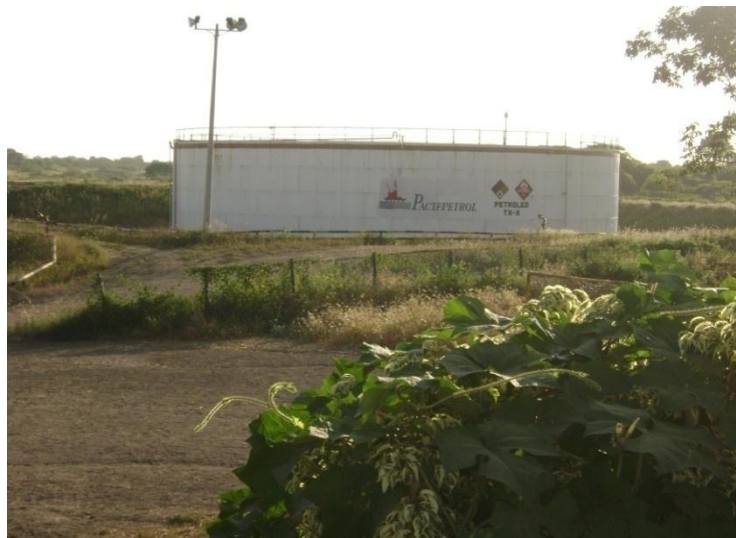
Fig. 2.8 Tanque primario o final (TK K)
