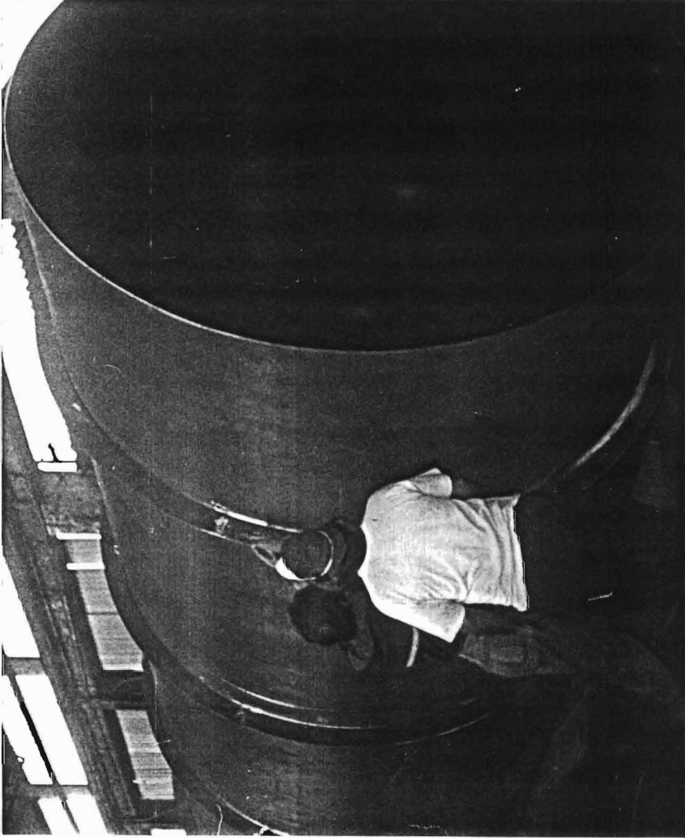
**FIG.3.5 COLOCACION DE ANILLOS DE REFUERZO EN TUBOS METALICOS**
