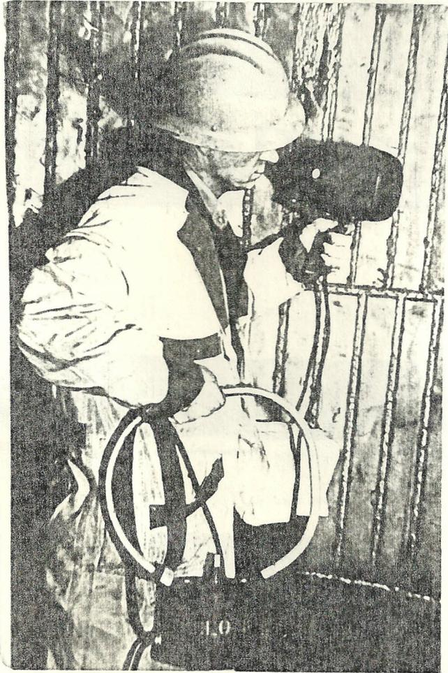
FIGURA A17. Inspección con partículas magnéticas fluorescentes.
