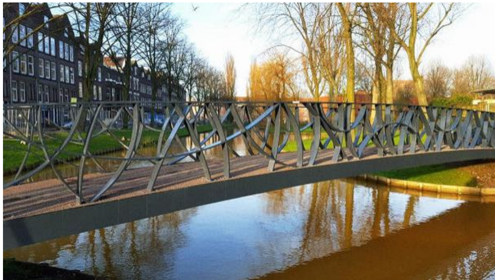
Figura 1.3 Puente de polímero reforzado con fibras en Rotterdam
