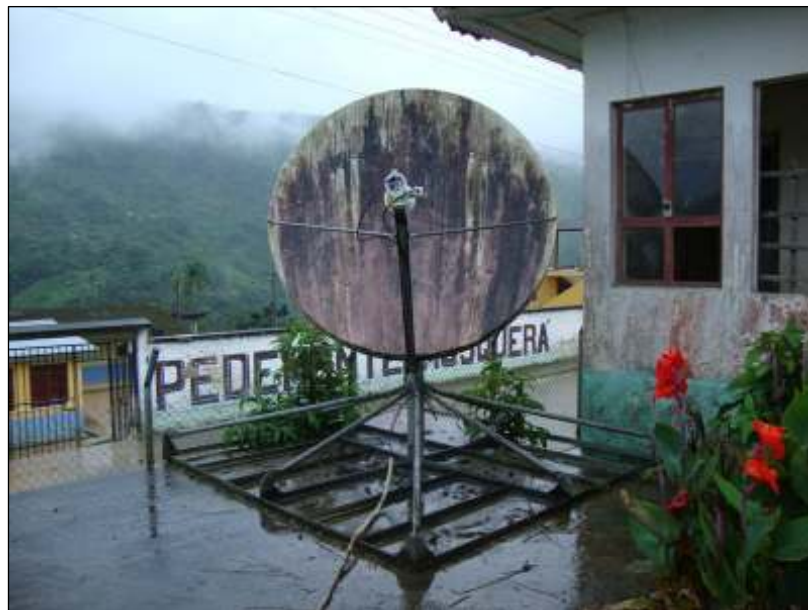
Figura E.7 Antena Satelital de 1.2 m ubicada en teleconsultorio de Yacuambi
