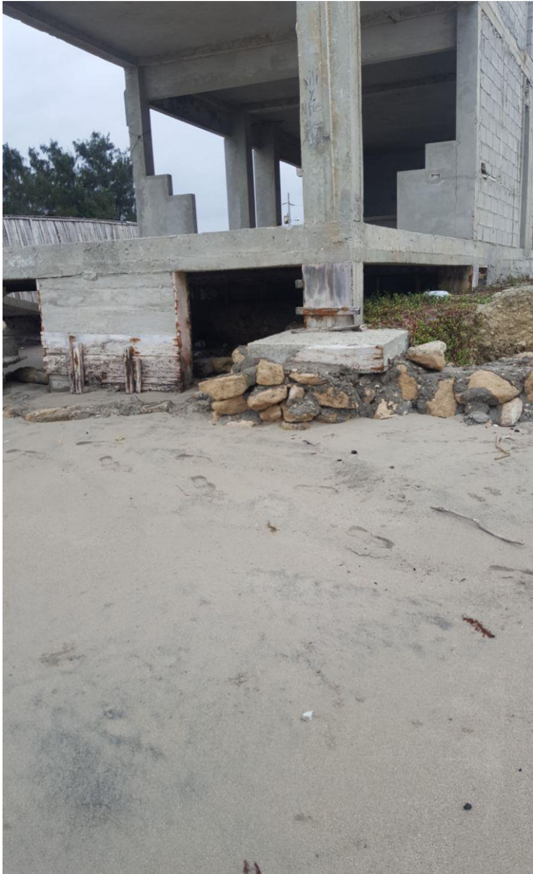
Imagen 7. Casa en proceso de construcción.
