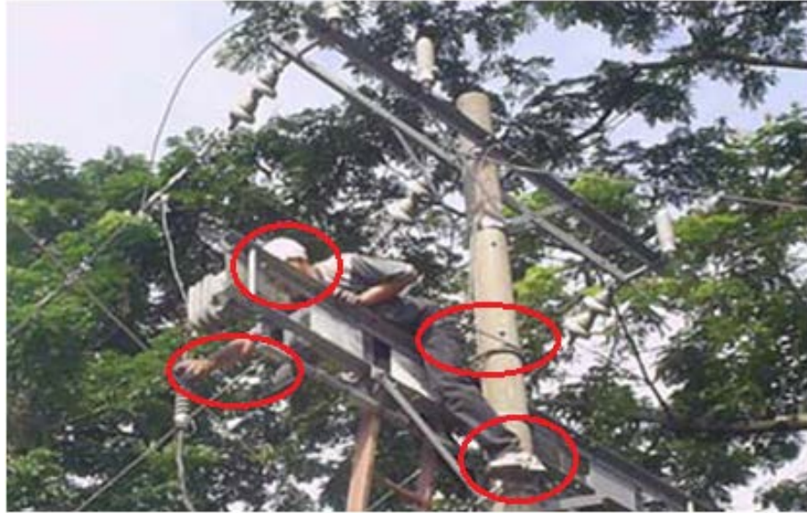
Figura # 5.4. Trabajo sin tensión
