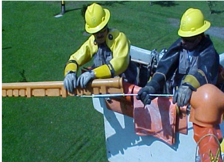
Figura # 5.6. Trabajos con tensión
