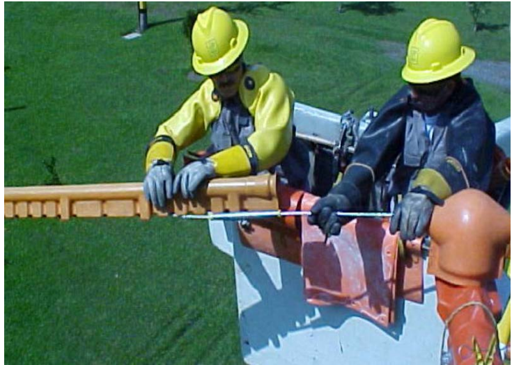
Figura # 4.9. Trabajos a contacto
