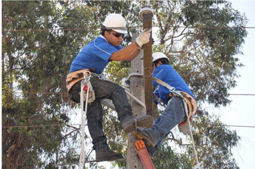
Figura # 5.5 Control de trabajos sin tensión
