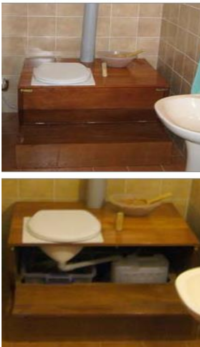
Figura 6. Modelo de Sanitario Ecológico
