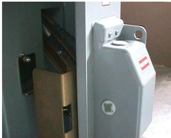
Figura 2. 3 Micro-switch encapsulado.
