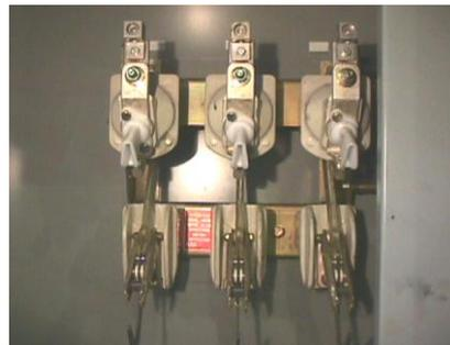
Figura 2. 4 Seccionador Vista frontal.
