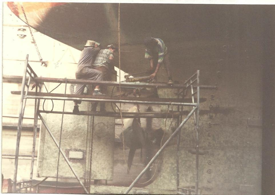
Fig.- 17. Desmontaje del barón y pala del timón
