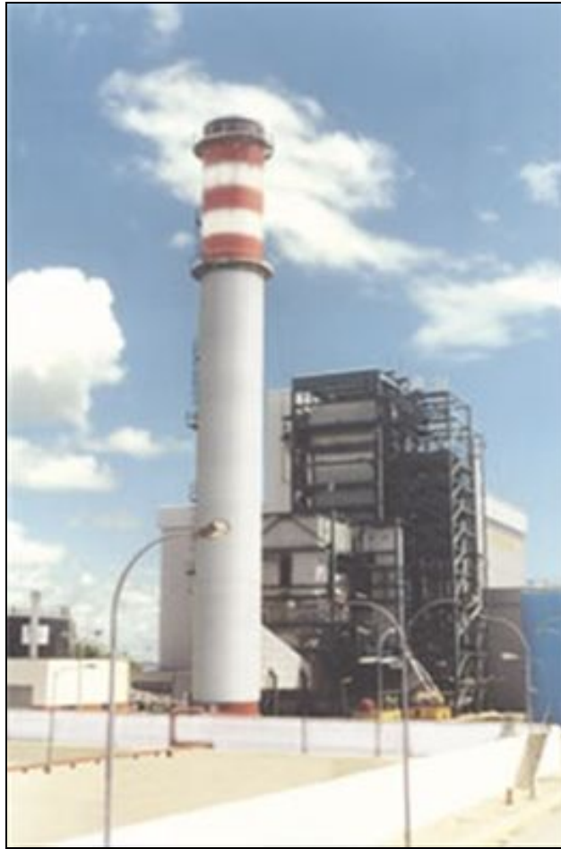
Figura 1.1 - Vista de la Central Térmica Trinitaria.
