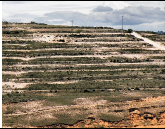
Figura 2.4: Zanjas de ladera
