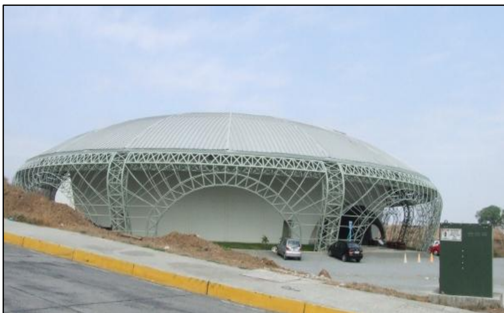
Figura 1-25 Edificio Centro de Tecnologías de Información CTI.
