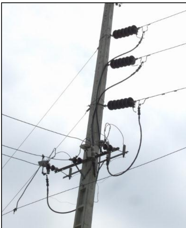
Figura 1-19 Protección con Tiras Fusibles.
