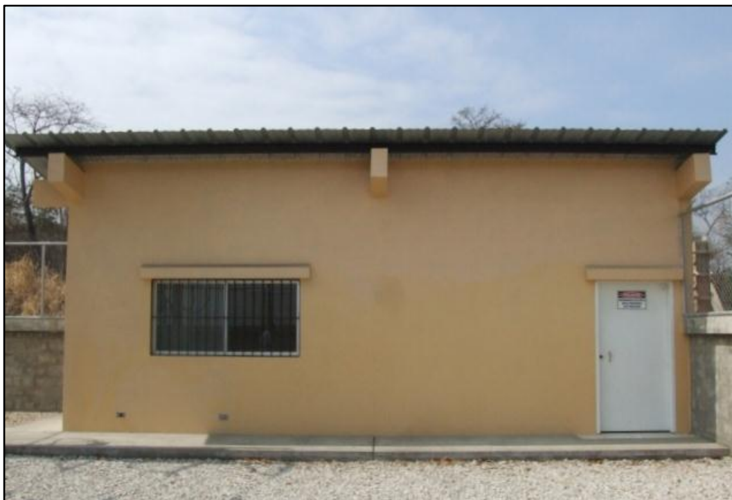
Figura 1-12 Cuarto de Control.
