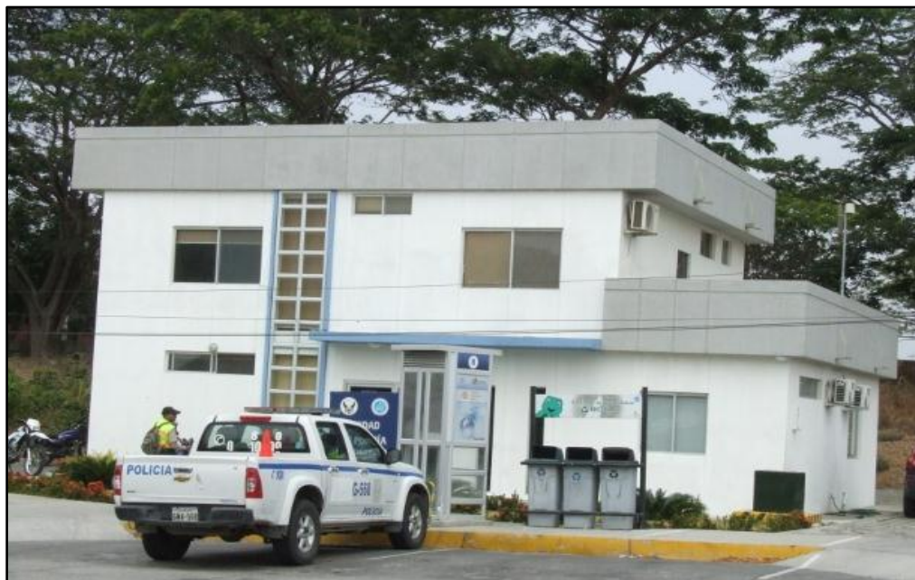
Figura 1-23 Edificio del UPS.
