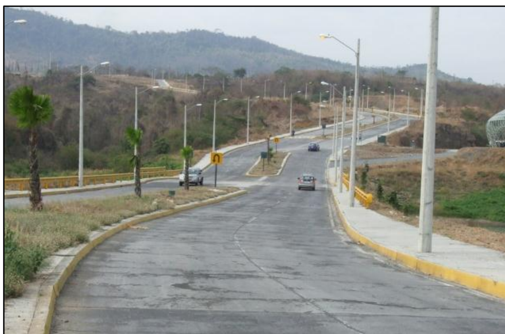
Figura 1-24 Iluminación de la Carretera PARCON.
