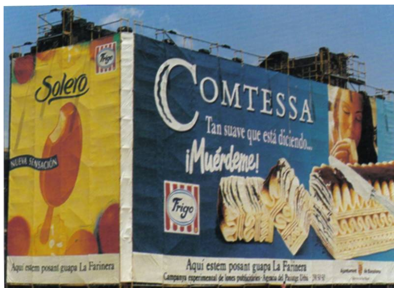
Lona con auspiciante de campaña "Barcelona posa't guapa" que cubre la instalación industrial de Harina- La Farina- mientras era restaurada.
