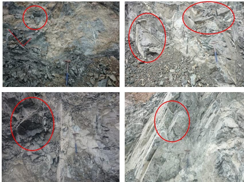
Imagen 3.5.- Estructura de cuña en los frentes de las EGMs (de izquierda a derecha y de arriba hacia abajo EGM1, EGM2, EGM3, EGM4) (Autores, 2018)
