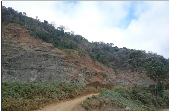
Imagen 2.2.- Fotografía de la situación actual de la cantera (Autores, 2018)
