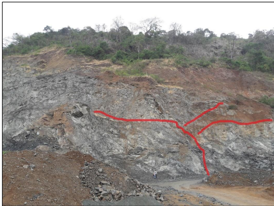
Imagen 3.2.- Afloramiento con intercalaciones con material arcilloso (Autores, 2018)
