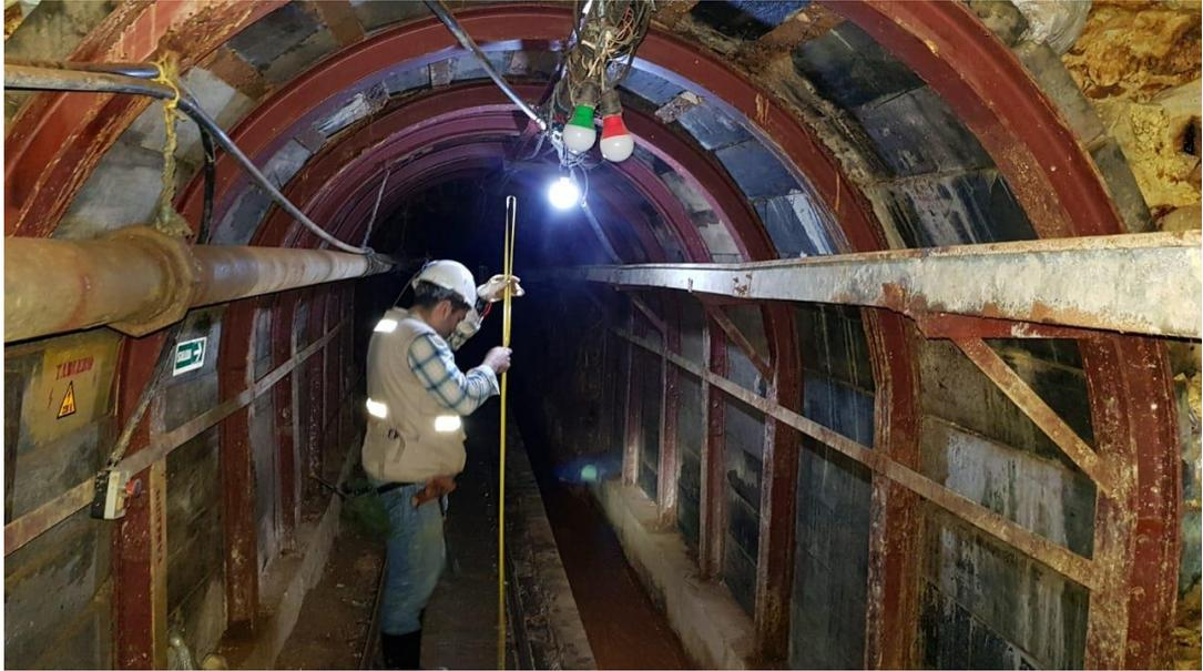
**Figura 4.12.- Fortificaciones de hierro y madera en excavaciones.**
