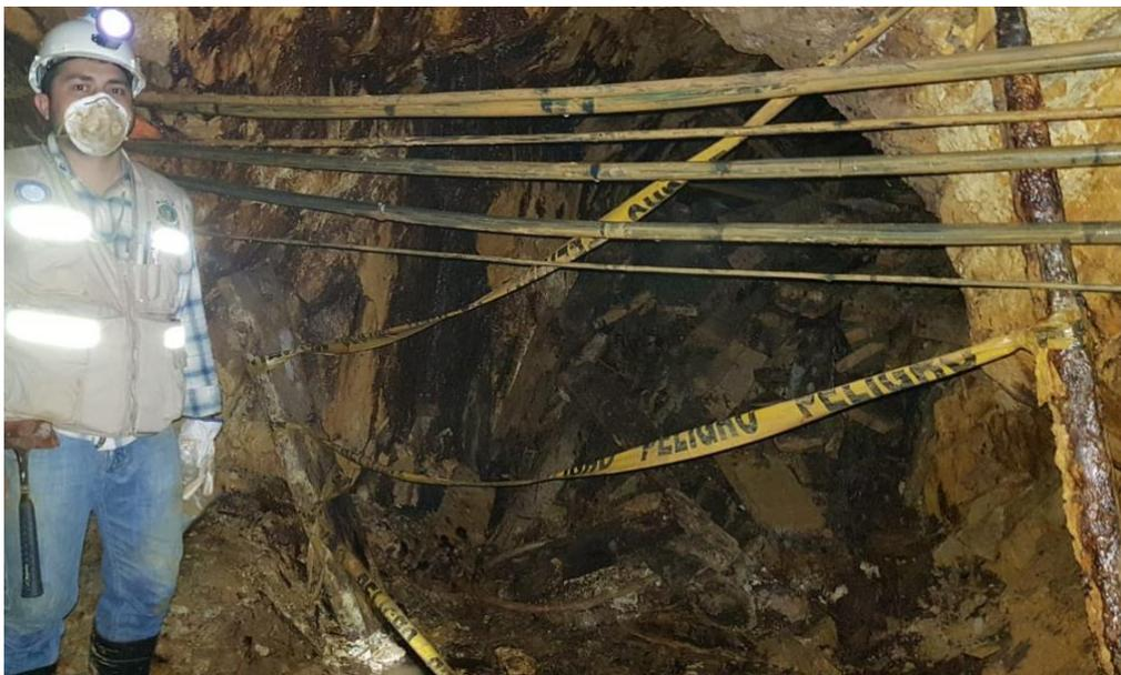
**Figura 4.8 Zona de derrumbe que queda en el sector B, correspondiente a la estación EG19.**
