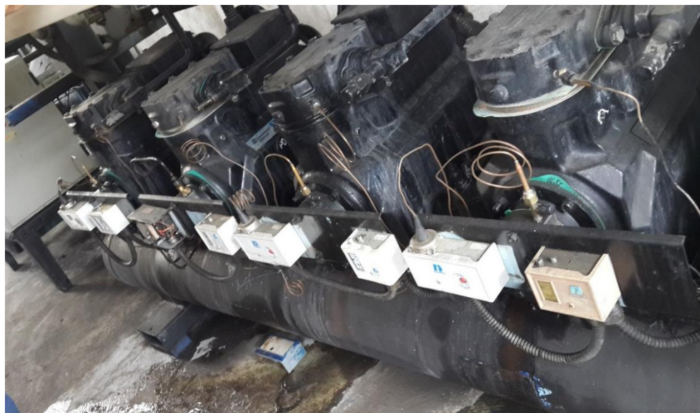
Figura 2.4. Sistema de compresión en paralelo para refrigeración HUSSMAN (Compresores).
