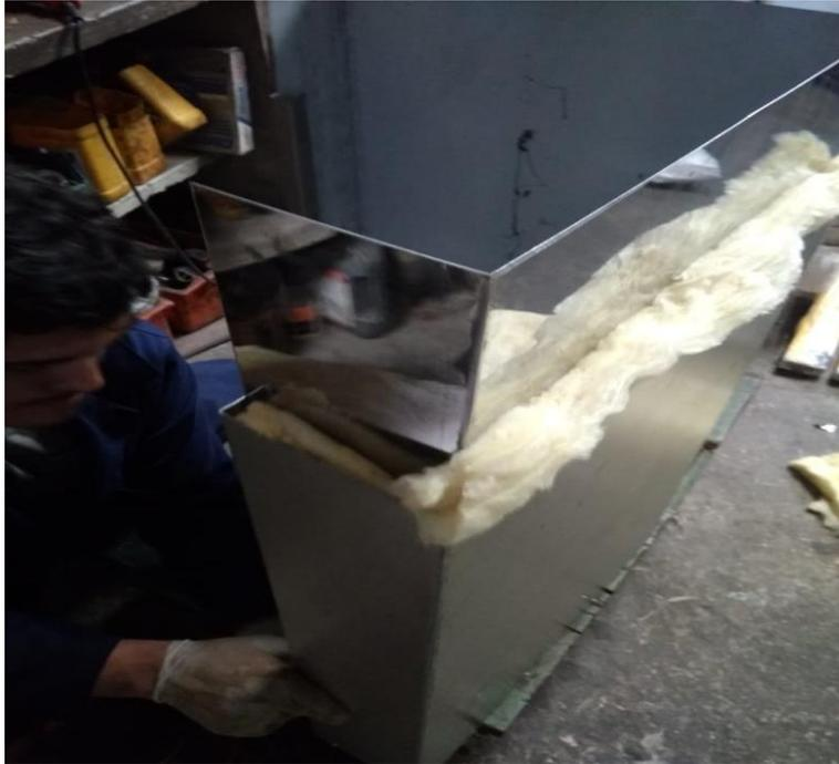
**Figura A. 3 Traslapado entre cara exterior e interior de la cámara**
