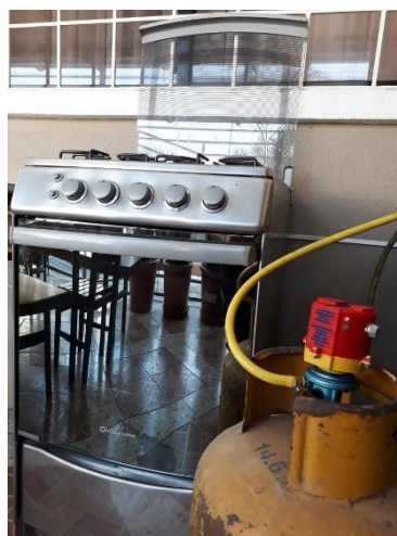
Figura 3.11 Dispositivo final instalado
