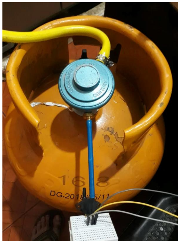
Figura 2.6 Conexión entre el sensor MPX10DP y la válvula de gas
