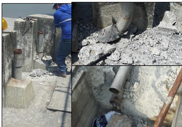
Figura A.2 Ductos y codos removidos.
