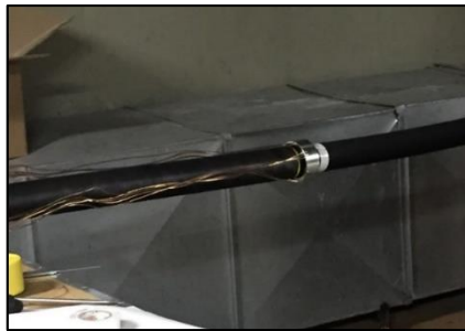
Figura 3.39 Colocación de anillo conductor.
