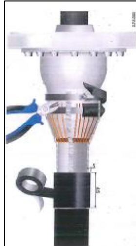
Figura 3.22 Contacto de pantalla a la prensaestopas NKT (2018).
