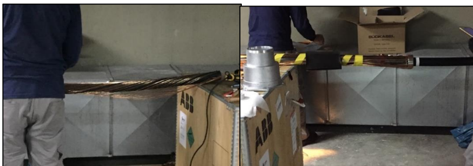
Figura 3.41 Entrelazado de cables de cobre y colocación de cinta.
