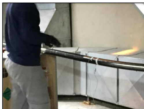
Figura 3.37 Limar la capa exterior dentro de los límites marcados.
