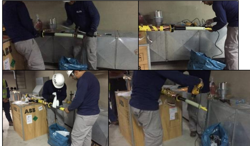
Figura 3.45 Grafitación del núcleo sobre aislamiento desprendido.
