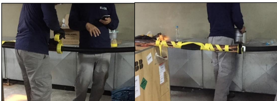
Figura 3.42 Colocación de capa de cinta auto conductora amalgante.
