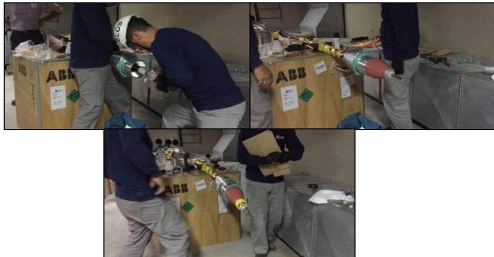
Figura 3.47 Instalación del conector superior.
