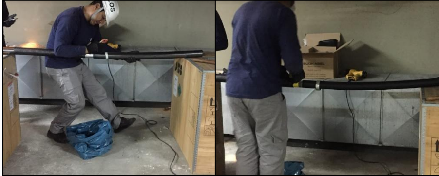
Figura 3.38 Aplicación de calor para extracción de capa.
