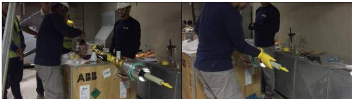
Figura 3.46 Colocación del tubo termo contraíble.
