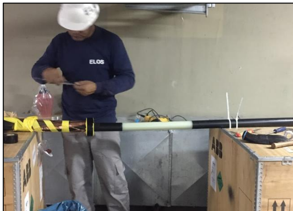
Figura 3.43 Preparación para el desprendimiento del aislamiento.
