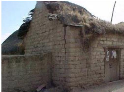
**Figura 1.15 Grieta en la parte inferior del tímpano (Miranda, 2010)**
