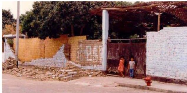
Figura 1.18 Falla de muro fuera del plano (Miranda, 2010)
