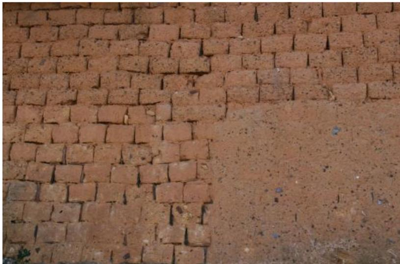
**Figura 1.26 Muro de adobe erosionado (Campos, 1993)**
