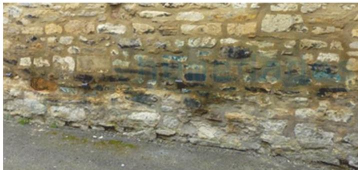
**Figura 1.25 Muro afectado por la humedad (Campos, 1993)**
