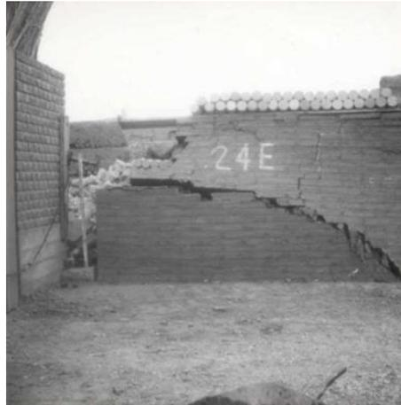
**Figura 1.19 Falla de muro a media altura (Miranda, 2010)**
