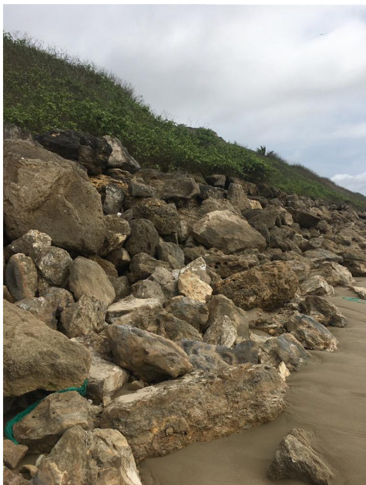
Figura 4.1 Condición actual del muro de contención
