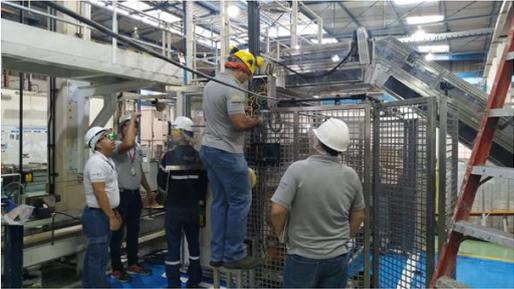
**Figura 2.32: Retirada de dispositivos de seguridad [Fuente: Steven Alvarado Lavanda]**
