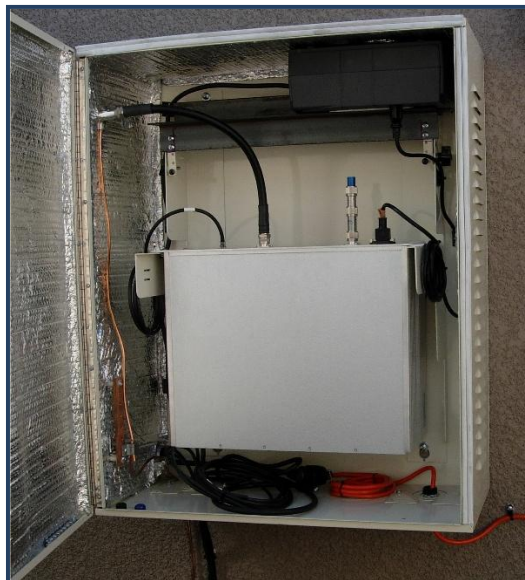
Fig. 4.11.- Instalación de la MacroMAX Base Station
