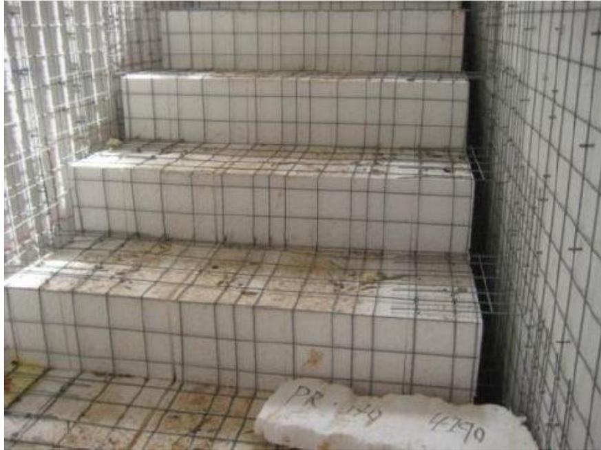
**Imagen 1.8 Detallamiento de escaleras con paneles EPS.**
